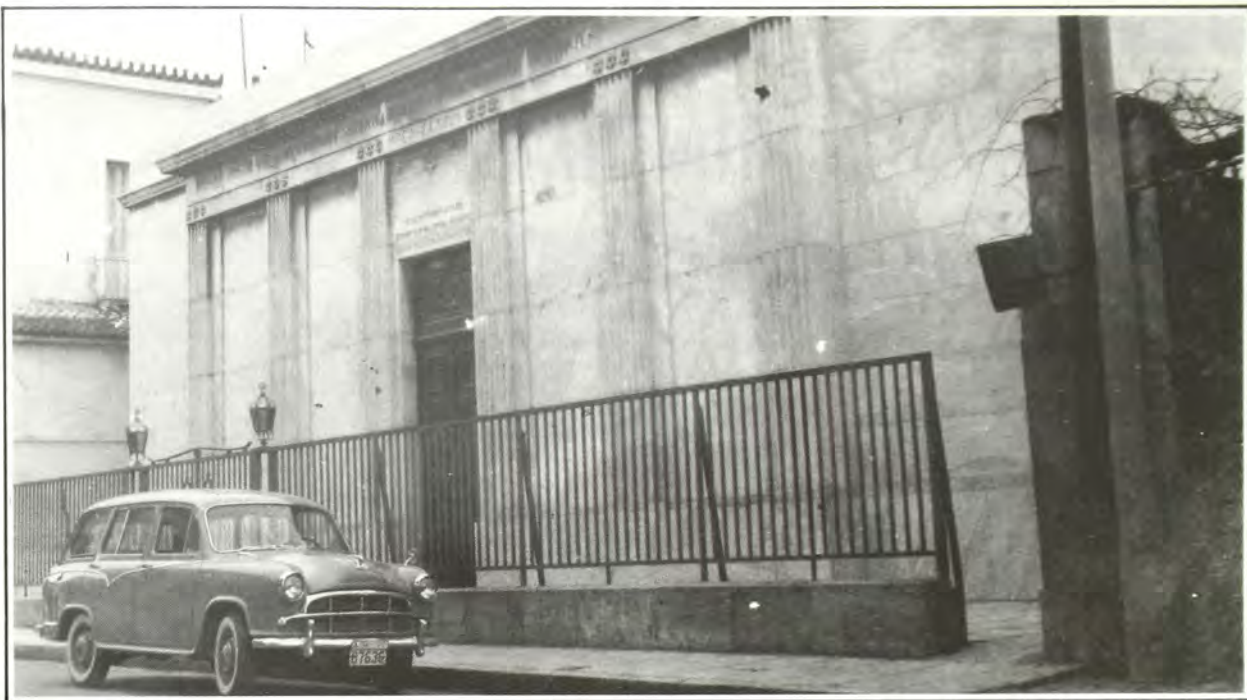
Ἐξωτερική ἀποψη τοῦ κτιρίου τῆς Συναγωγῆς.
